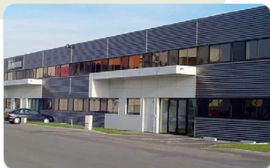
Creil Gourmay, bâtiment Varsovie ©CDC
