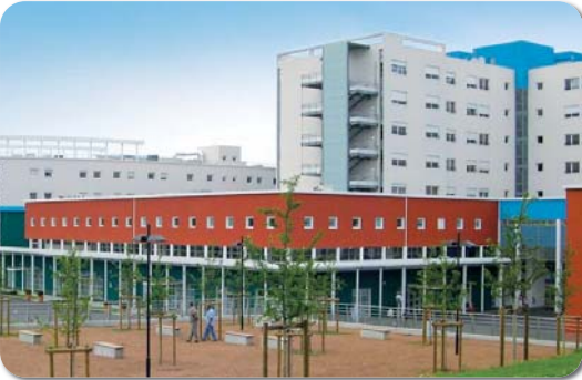
Saint-Etienne, Montchovet Centre de l'hospitalisation privée de la Loire ©CDC
