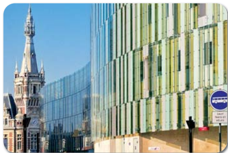
Tourcoing, Centre commercial Saint-Christophe ©Didier Alkenbrecher
