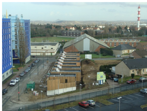
Quartier Grande Résidence : des maisons économes en énergie : les premiers logements THQE livrés à Lens
