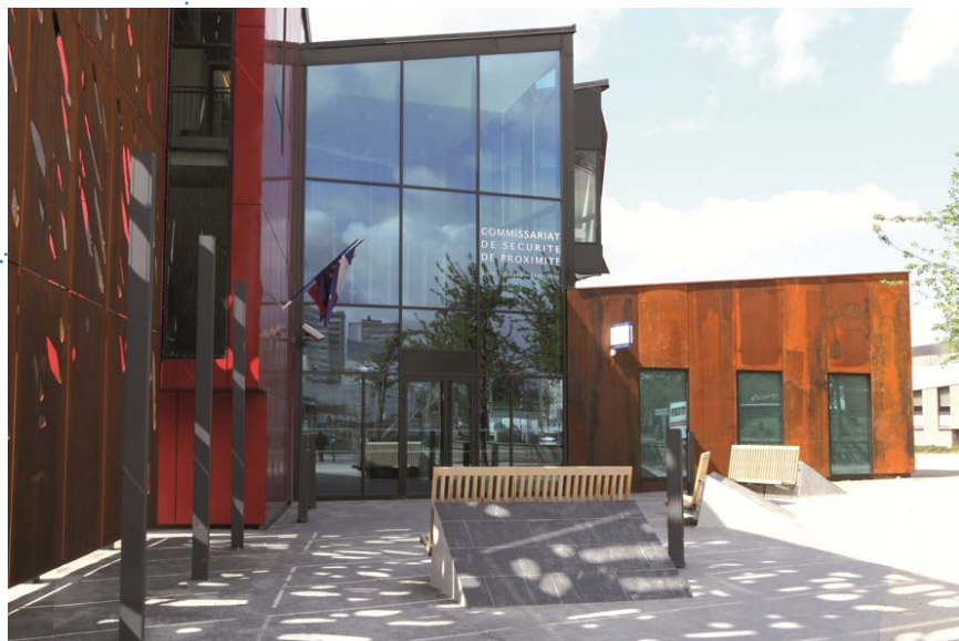
Clichy-Montfermeil quartier Le Plateau, Commissariat de sécurité de proximité
