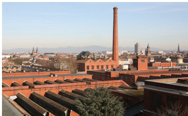
Le site DMC est typique des grands ensembles industriels du XIXe siècle, avec ses bâtiments en brique, ses sheds (toitures en dents de scie)... et ses cheminées.
